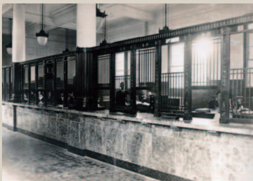
大和田銀行時代の 1 階カウンター
